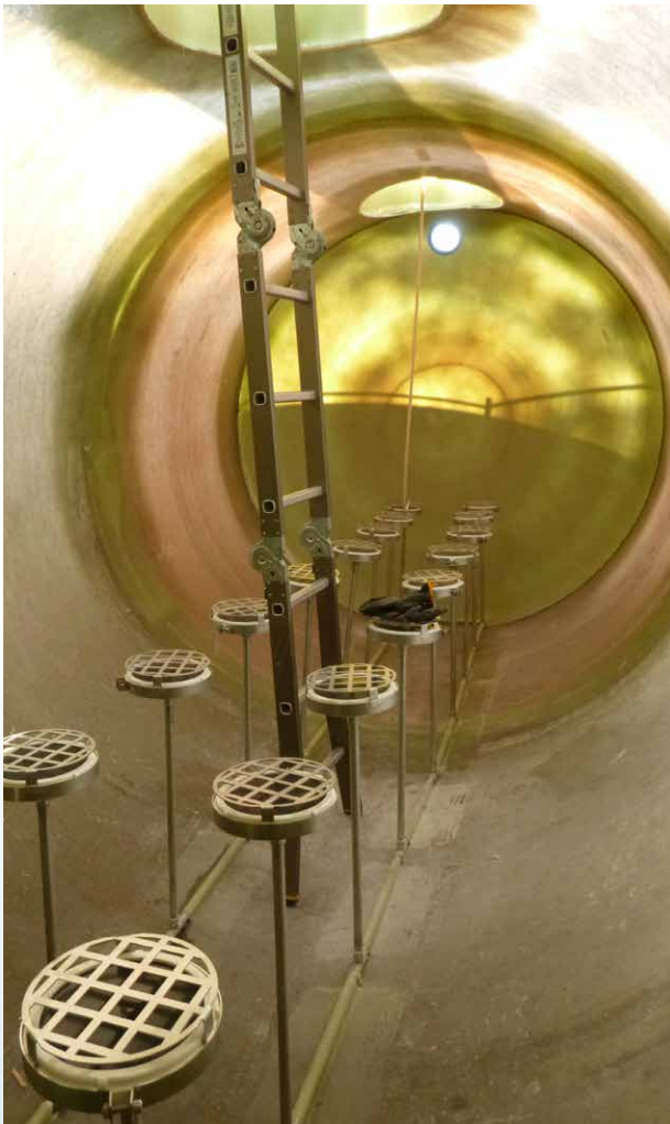
Bakterier tillsätts tillsammans med syre genom luftplattor.
